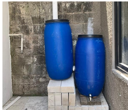
Gambar 4 pemasangan dan penyimpanan tangki pemanenan air hujan
