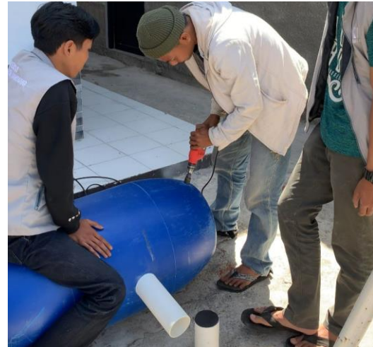
Gambar 2 Proses pembuatan sarana pemanenan air hujan (PAH)
